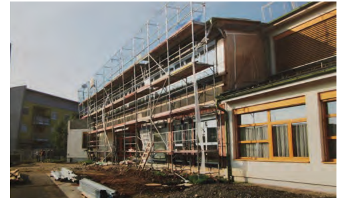
Der Umbau 2010/11 im laufenden Betrieb war schwierig für Lehrer, Schüler und die gesamte Baumannschaft
