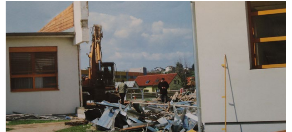
2010/11 wurde die Schule grundlegend umgebaut und modernisiert
